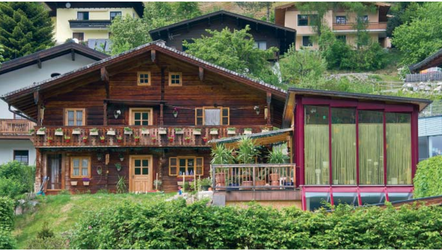
Das Gebäude heute: Rechts der moderne Anbau, der mit einem (scheinbar durchsichtigen) gläsernen Gang mit dem Haupthaus verbunden ist.
