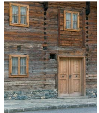
Oberhalb der Eingangstüre sind noch abnehmbare Balken zu erkennen.
